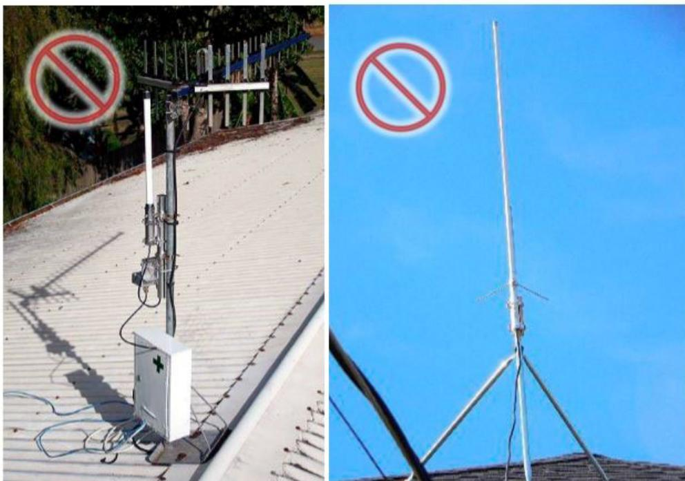
**Ошибка!** Телевизионная антенна и мачта искажают диаграмму направленности антенны (слева); антенна наклонена (справа).
