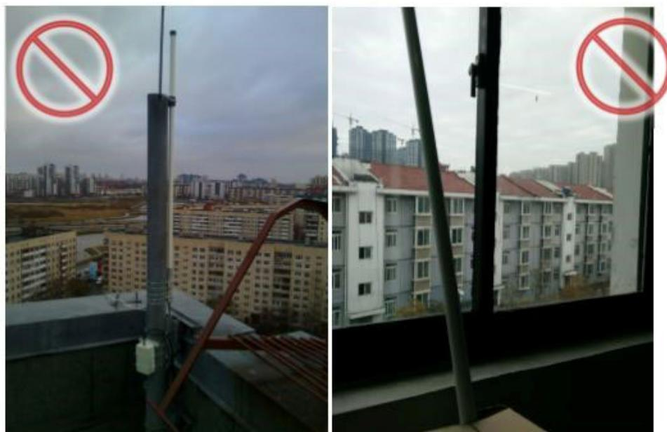
**Ошибка!** Мачта и молниевывод закрывают антенну, антенна слишком низко над парапетом (слева); антенна установлена в квартире жилого дома (справа).
