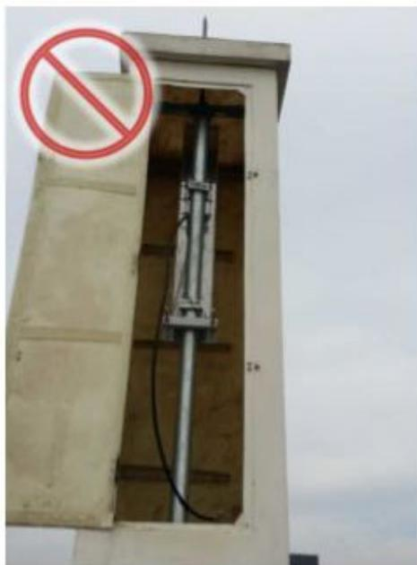
**Ошибка!** Антенна помещена в защитный корпус с металлическими остовами.
